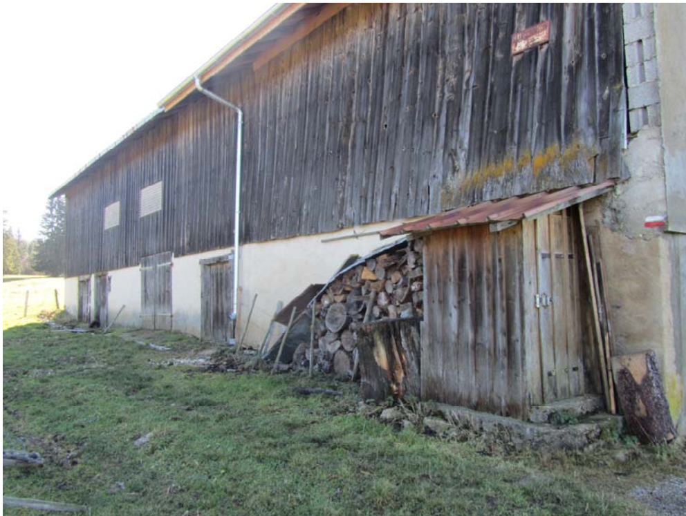
La maison est profonde. Ici façade nord-est.
