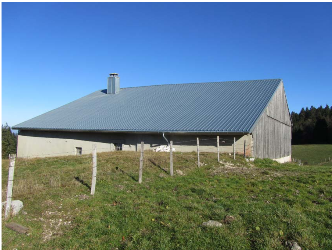
Façade sud-ouest et arrière nord-est.
