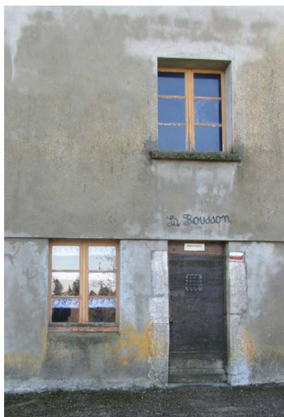
Trop de béton pour la Grange à Bousson !
