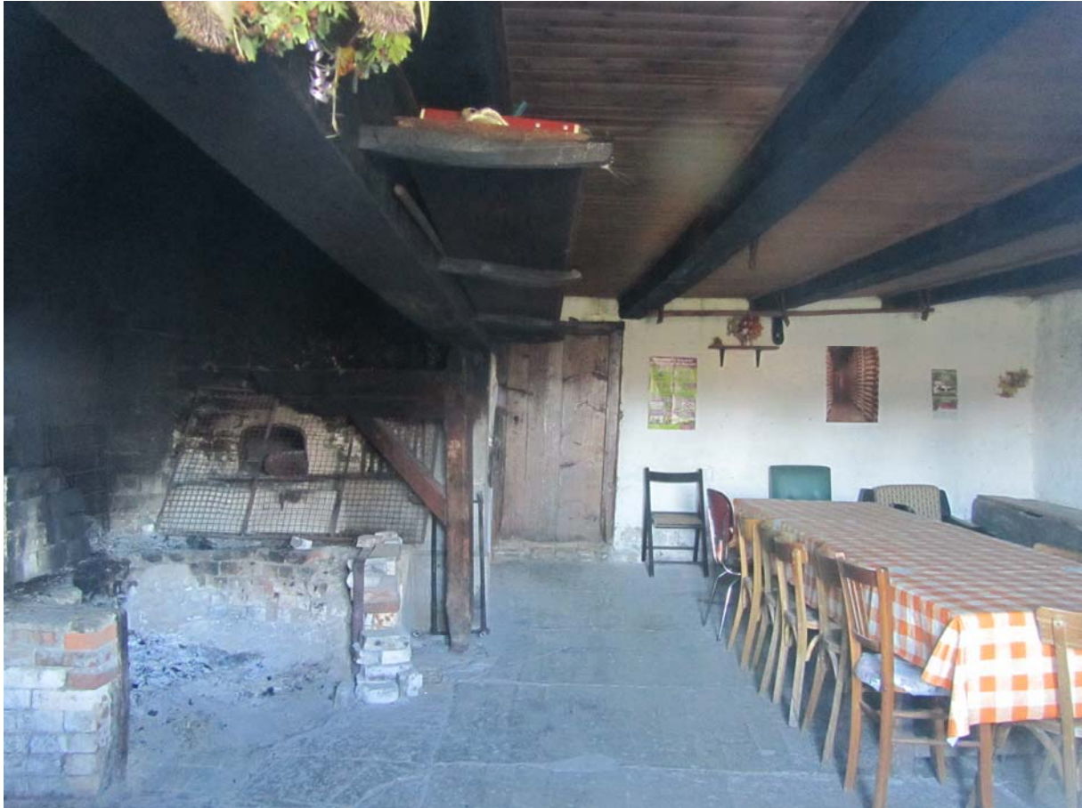
Une cuisine accueillante où demeure la betse ou le balancier au bout duquel était suspendue la chaudière que l'on pouvait positionner en travail sur le Creux de feu. Ici avec un entourage de brique.
